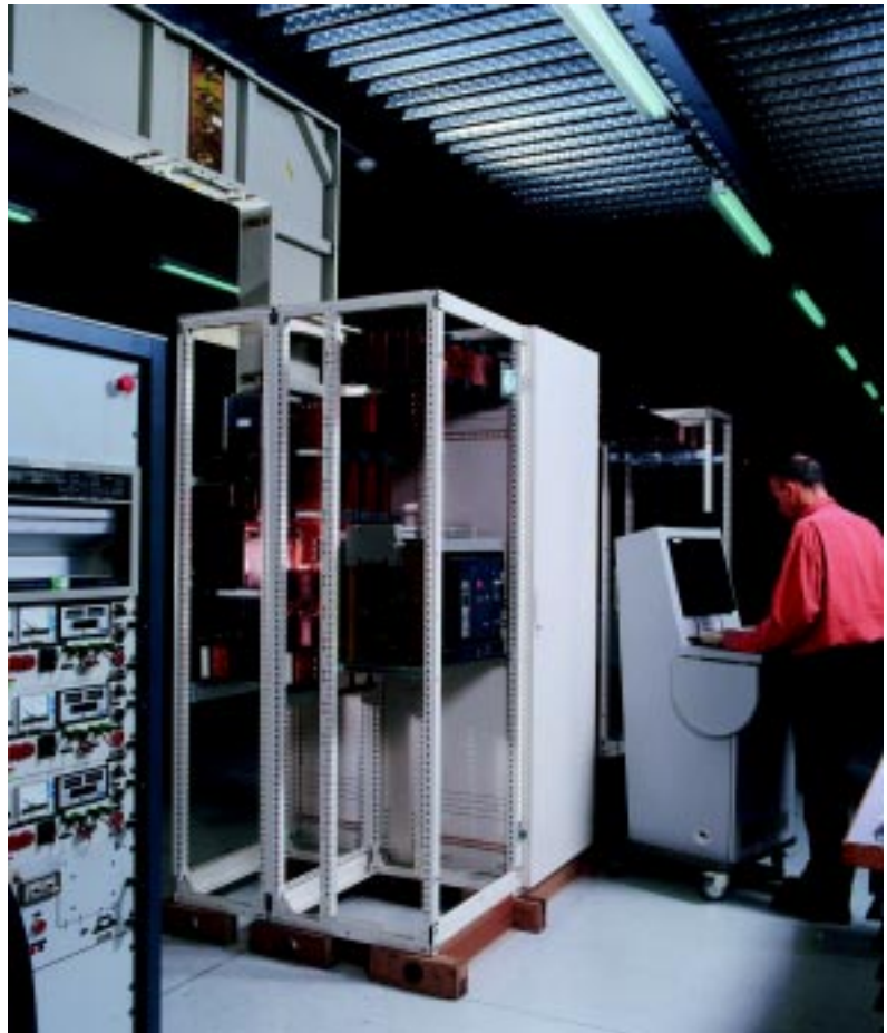
Preparação de um ensaio de aquecimento do quadro P4000 em plataforma. O Masterpact NW40 é ligado por Canalis.
